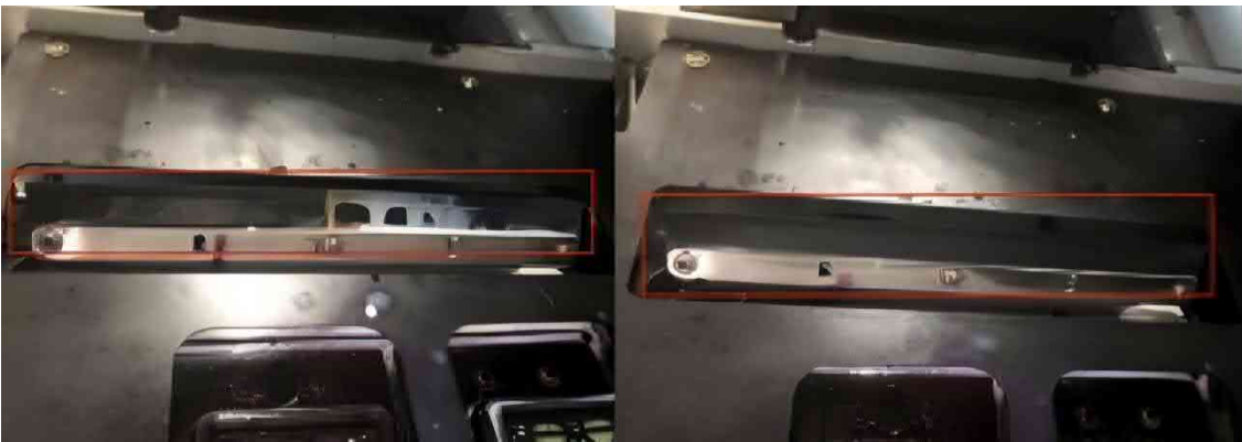
清理前（Before cleaning）
